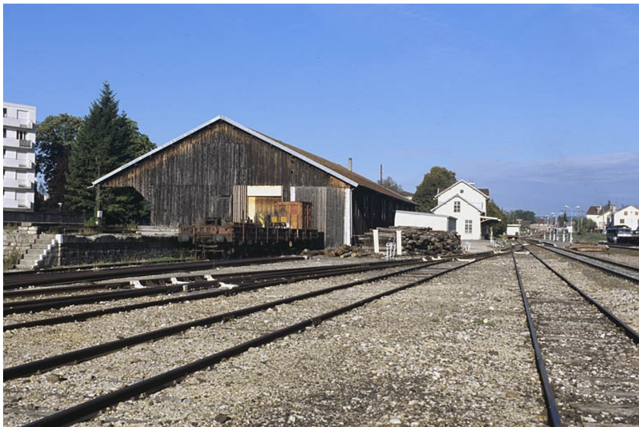
Entrepôt : vue d'ensemble, depuis le sud-est.
