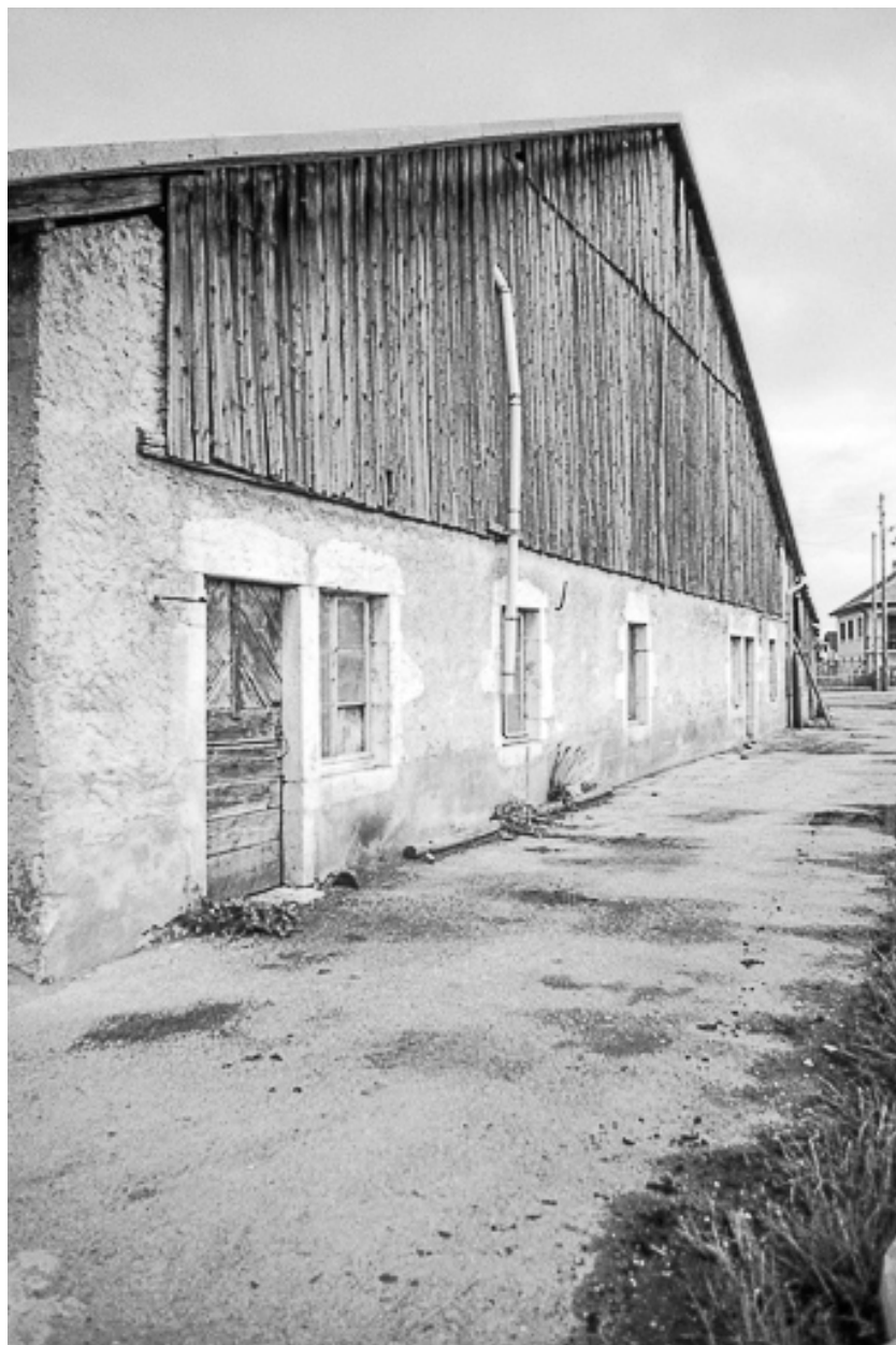
Ferme cadastrée 1962 E 11 : façade antérieure.
