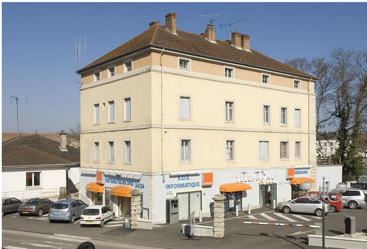
Bâtiment des logements et bureaux.
