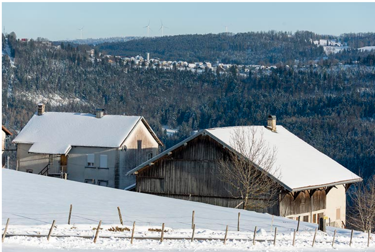
Ferme et logement en hiver, depuis l'ouest.
