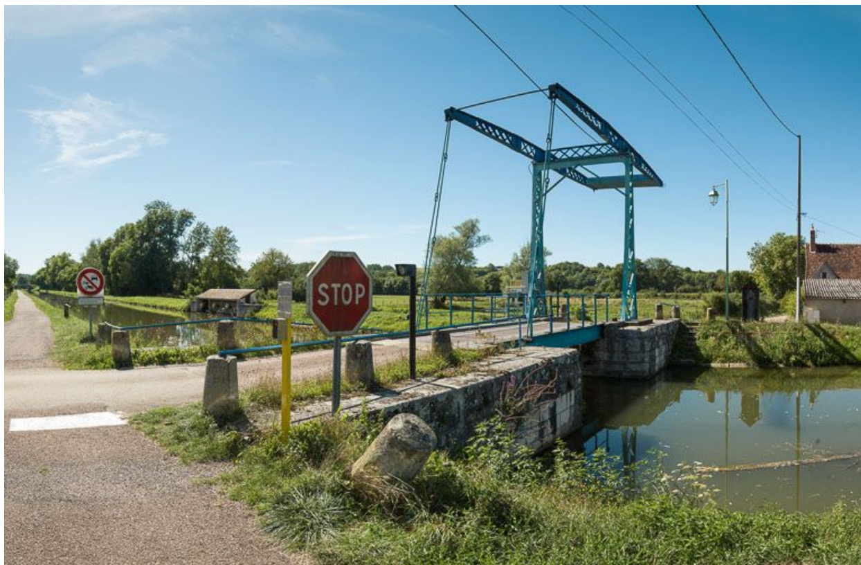
Vue d'ensemble du pont.
