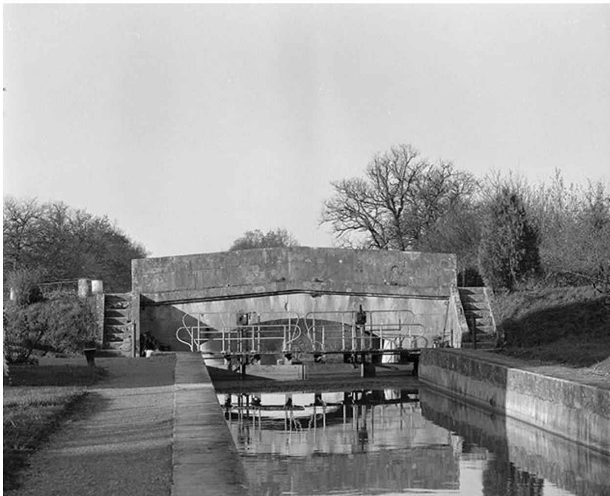
Le pont. Vue prise de l'amont.
