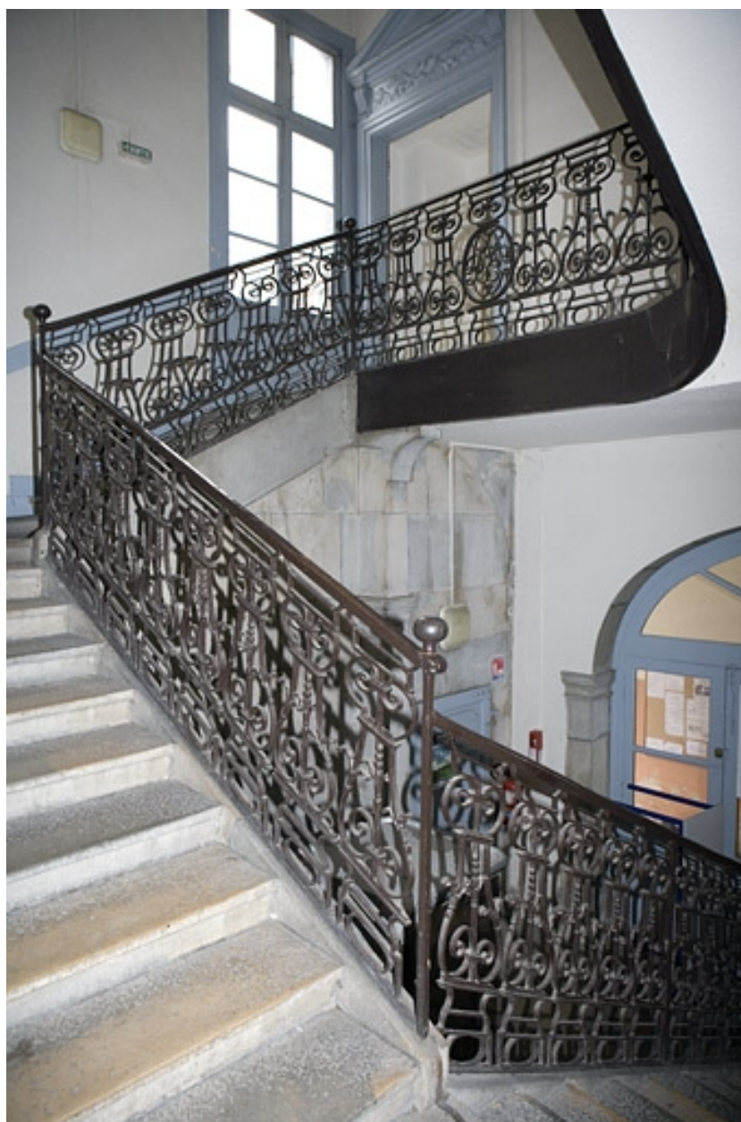
Vue d'ensemble de l'escalier.
