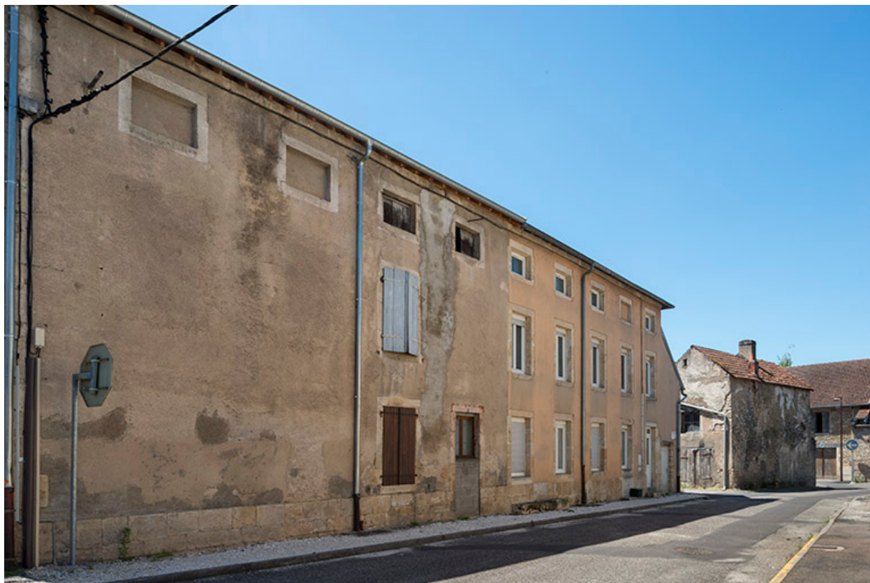
Élévation extérieure sur la rue des Fours.
