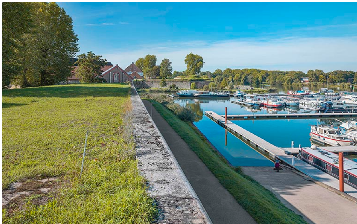
Terre-plein, parapet (face ouest).
