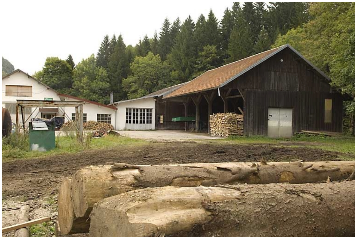
Partie nord : hangar.
