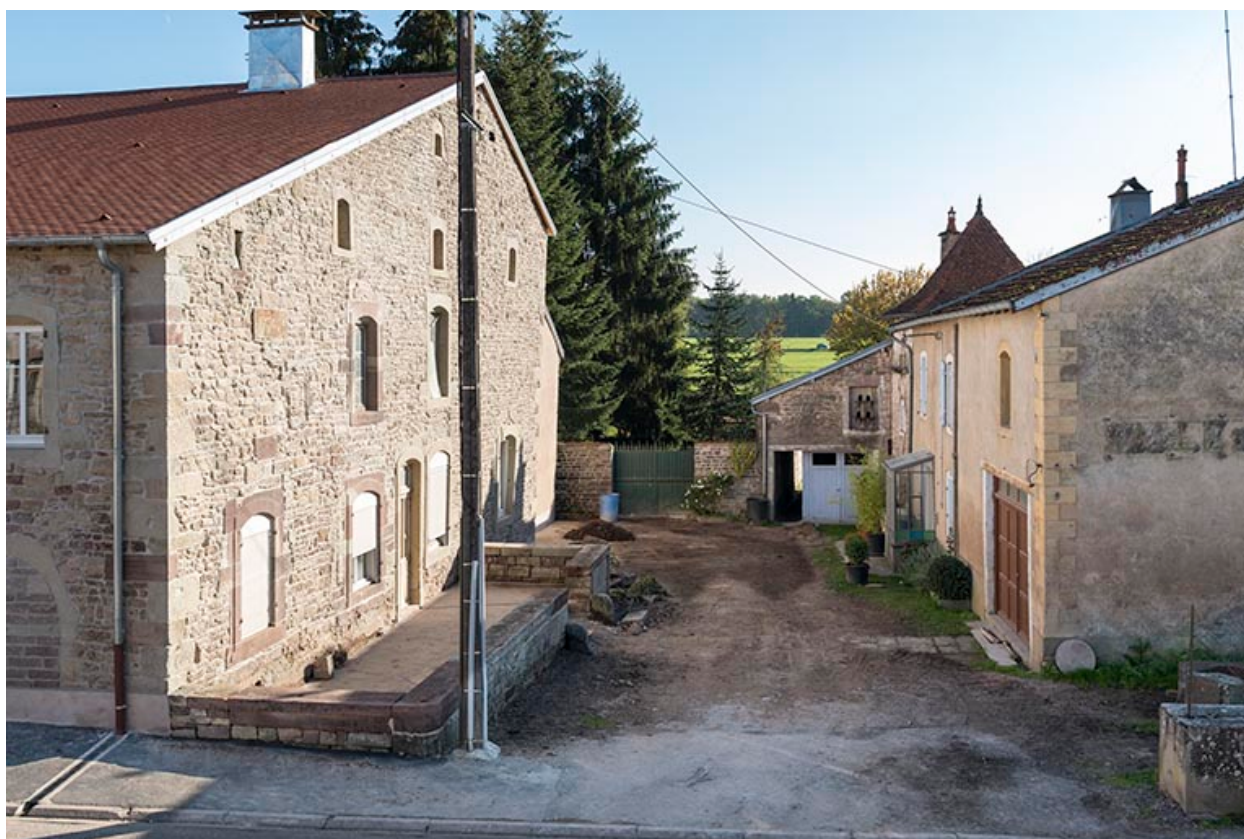
Vue du mur pignon ouest.
