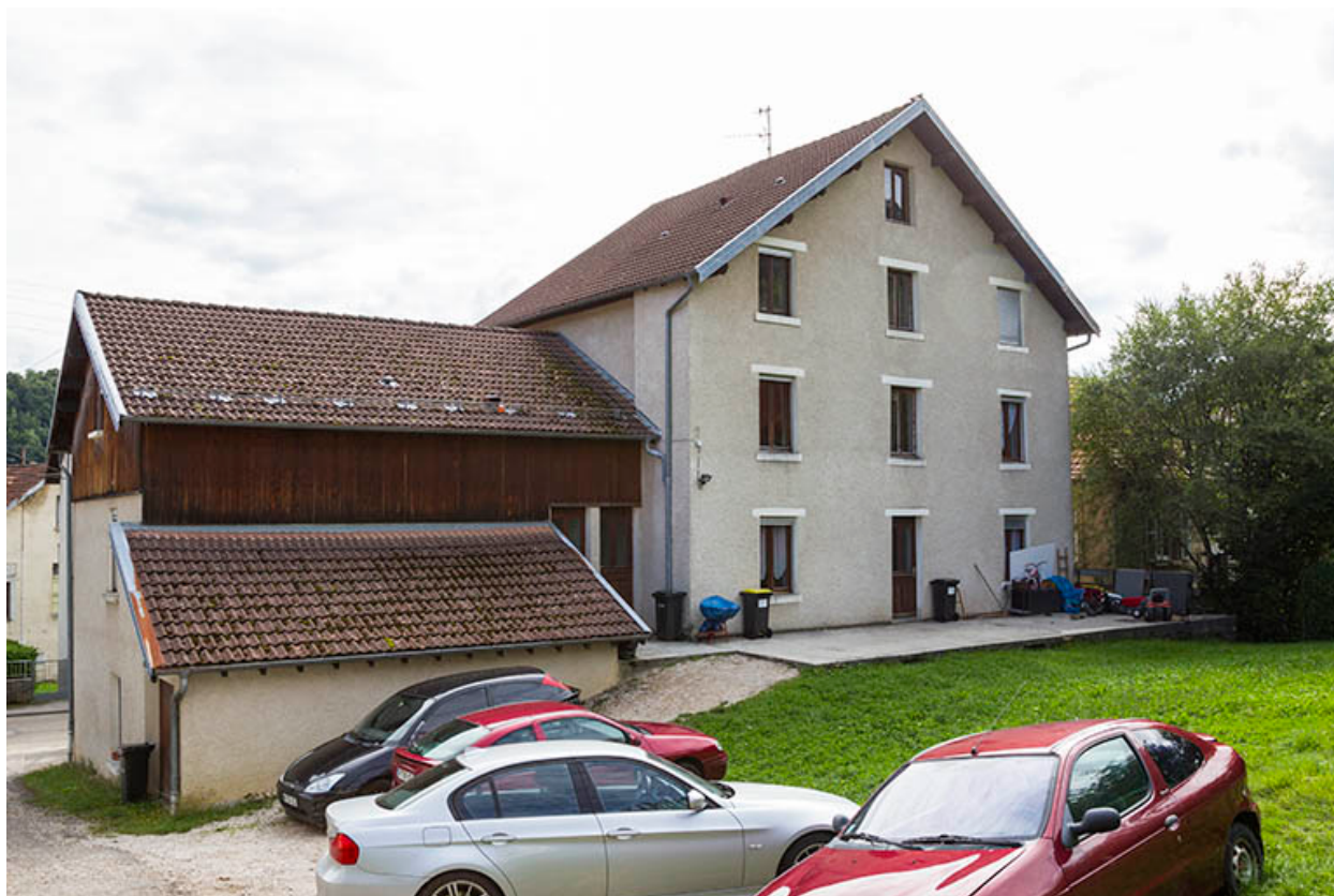
Façades postérieure et latérale droite.
