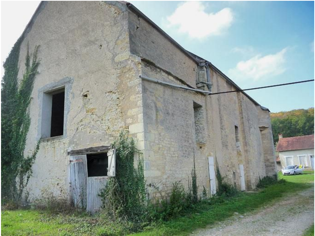
Murs postérieur et gauche de la chapelle.
