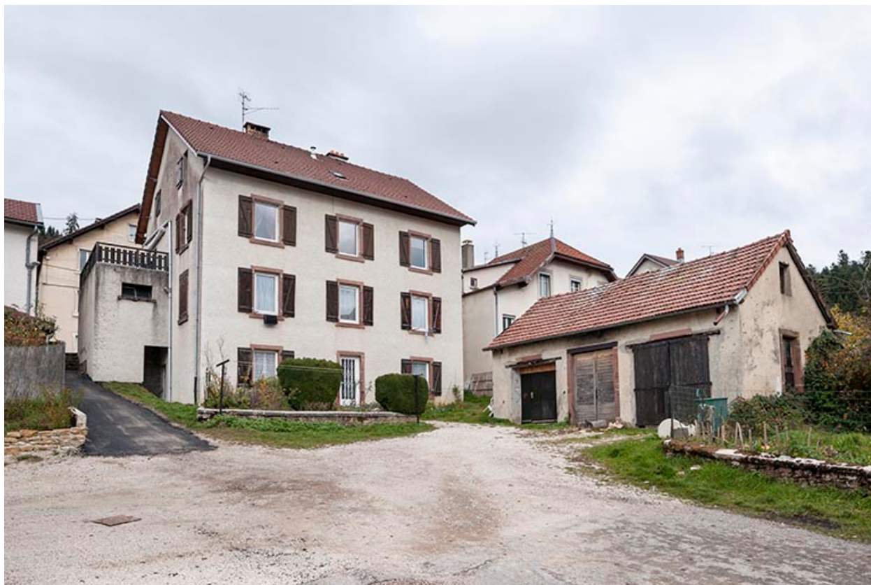
Façade postérieure et ancien atelier ou remise.
