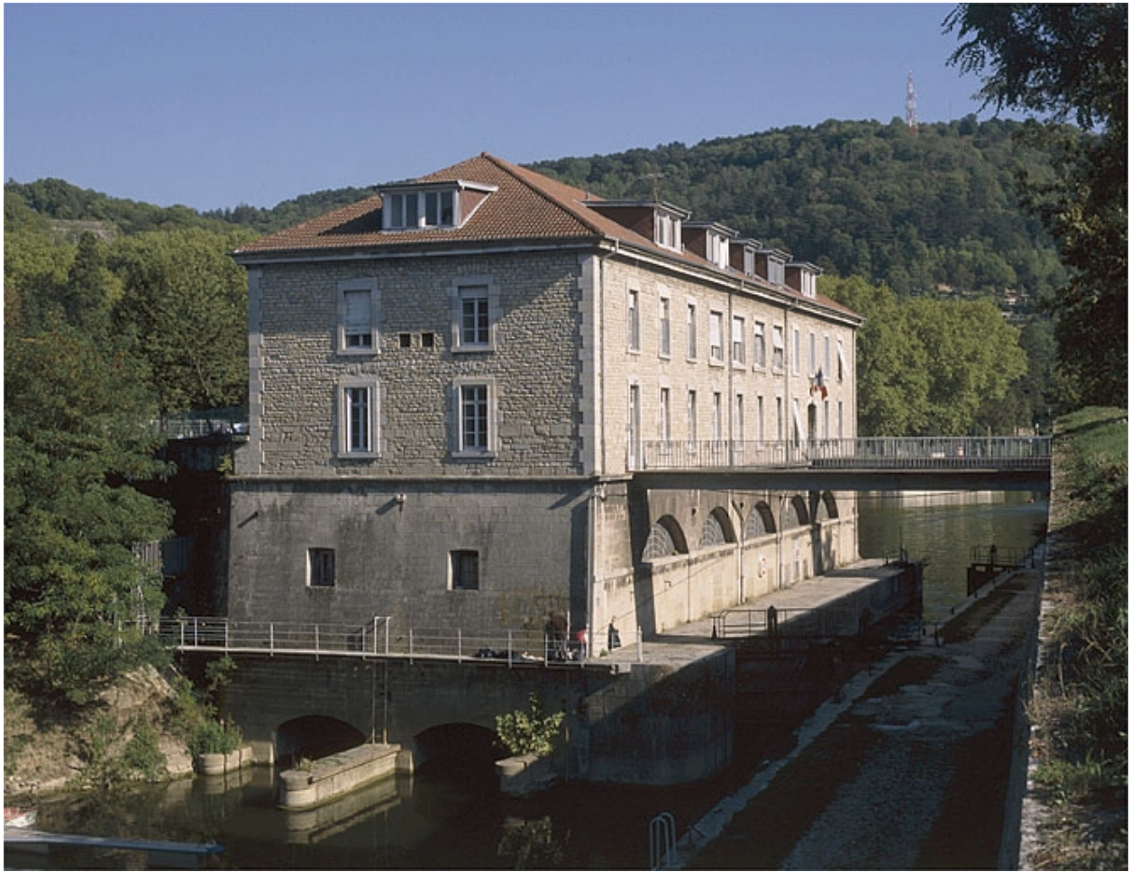
Le moulin de trois quarts gauche (aval).
