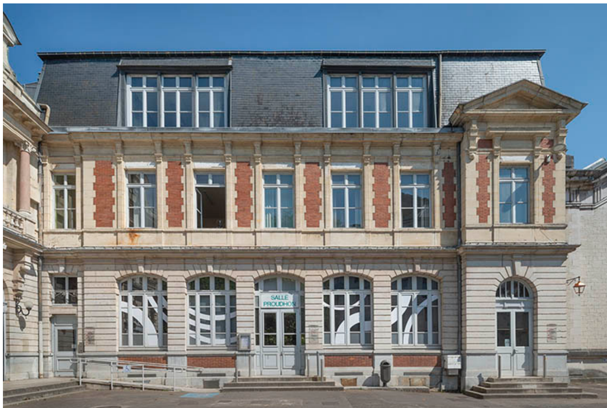
Ancienne brasserie (bâtiment Proudhon) : façade antérieure.
