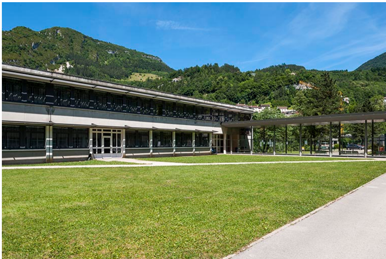
Externat tertiaire : façade antérieure.
