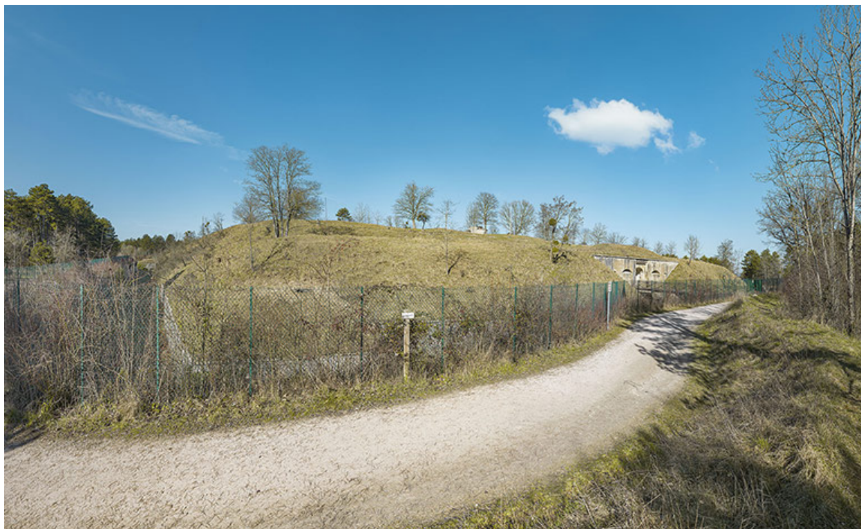
Le fort de la Motte-Giron : vue au saillant 1 côté contrescarpe.
