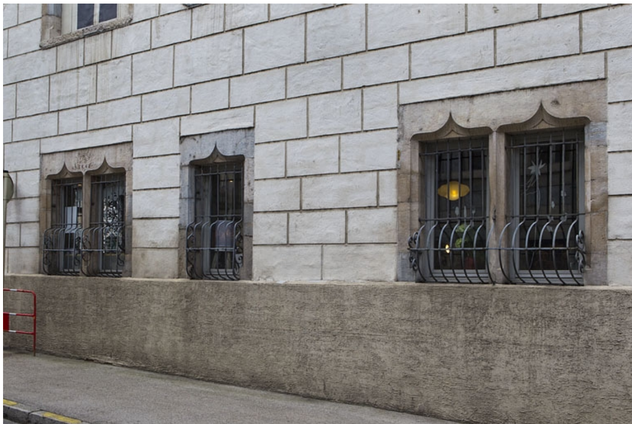
Façade latérale droite, détail du rez-de-chaussée.
