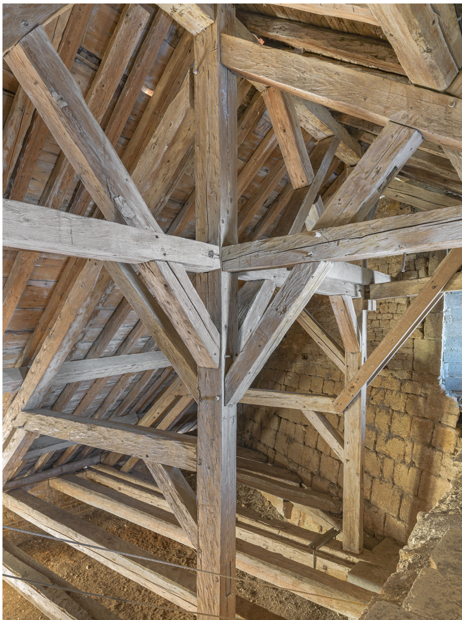
Pavillon d'entrée : détail de la charpente.
