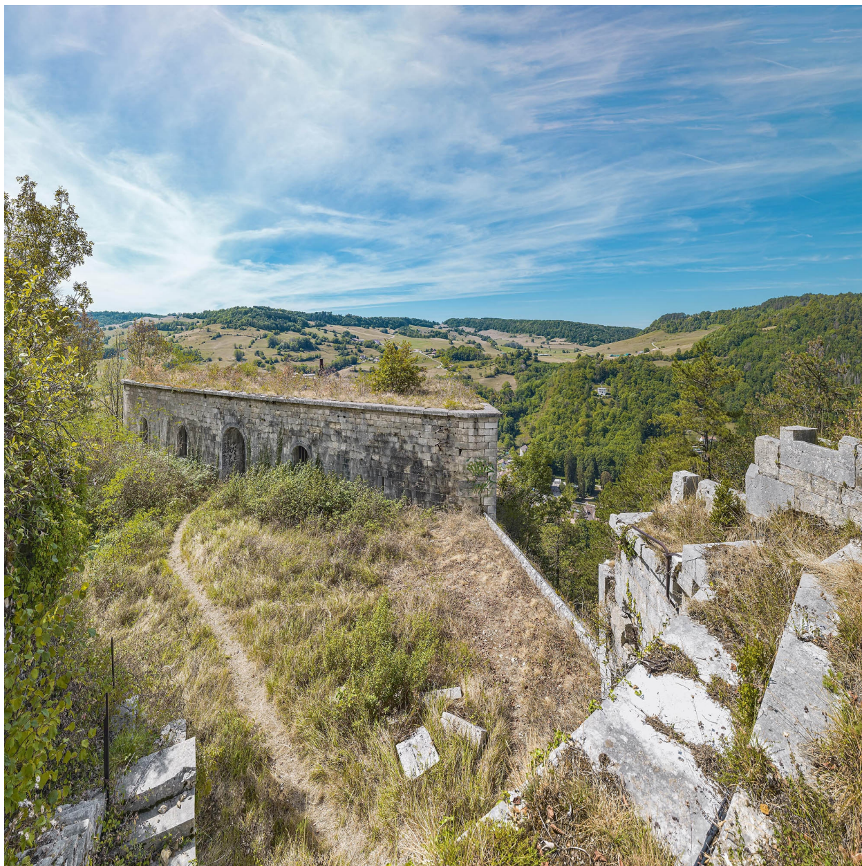
La plateforme et le réduit du bas-Belin.
