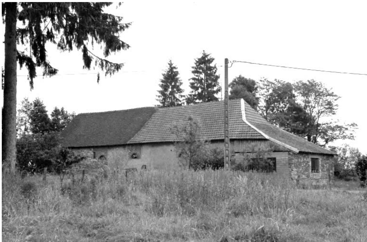
Atelier de fabrication (B), depuis le sud-ouest.
