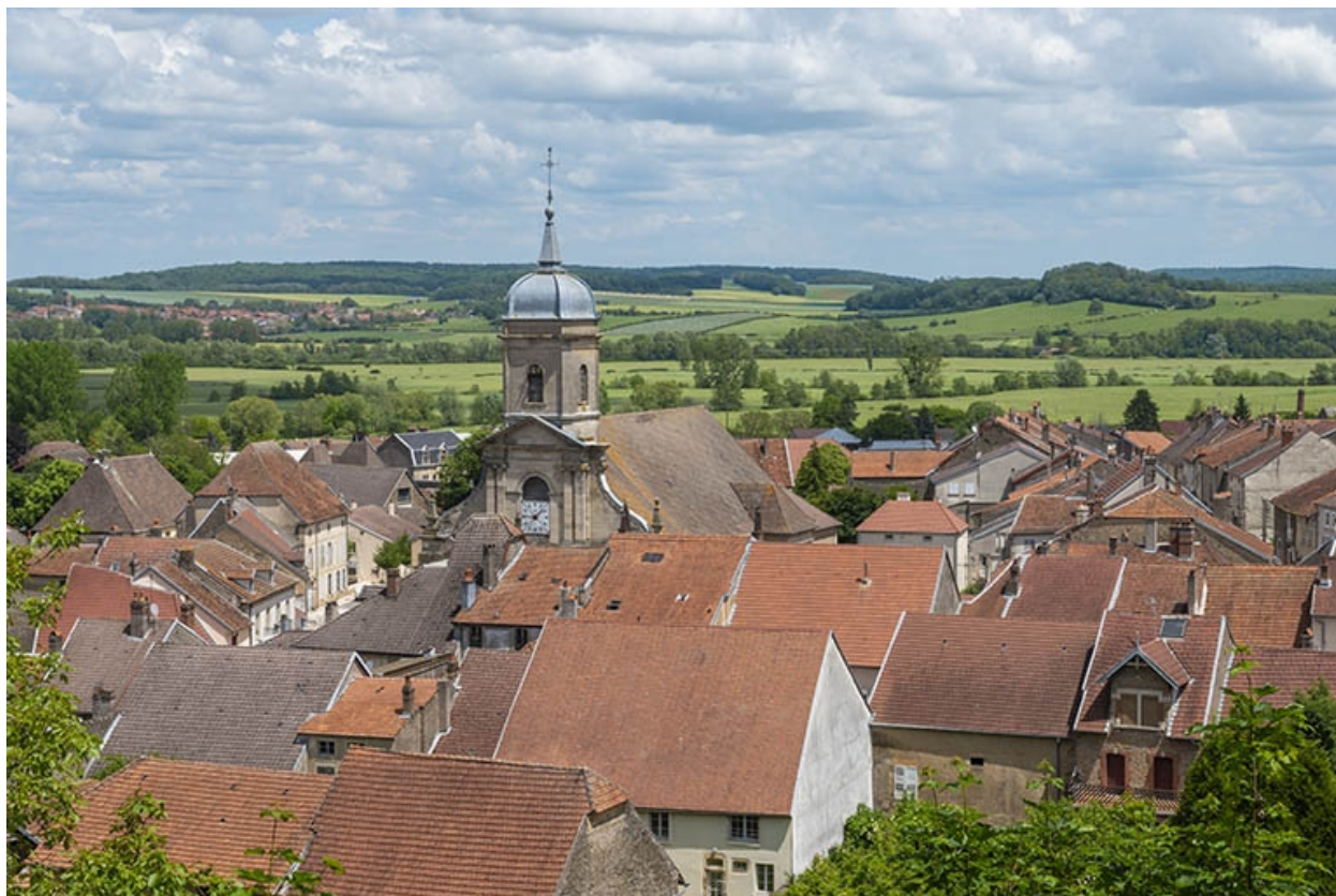
Vue générale depuis le sud-ouest.
