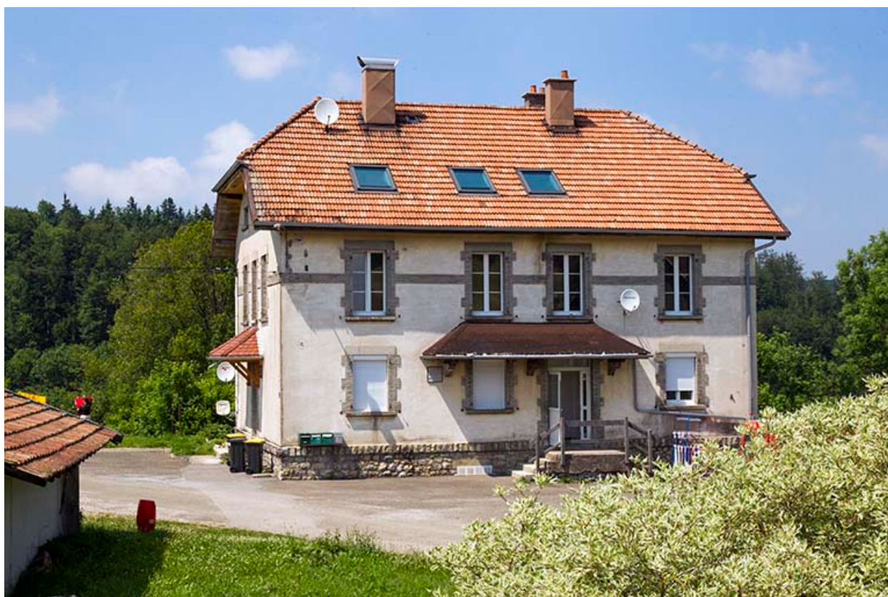
Façade latérale droite, de trois quarts gauche.
