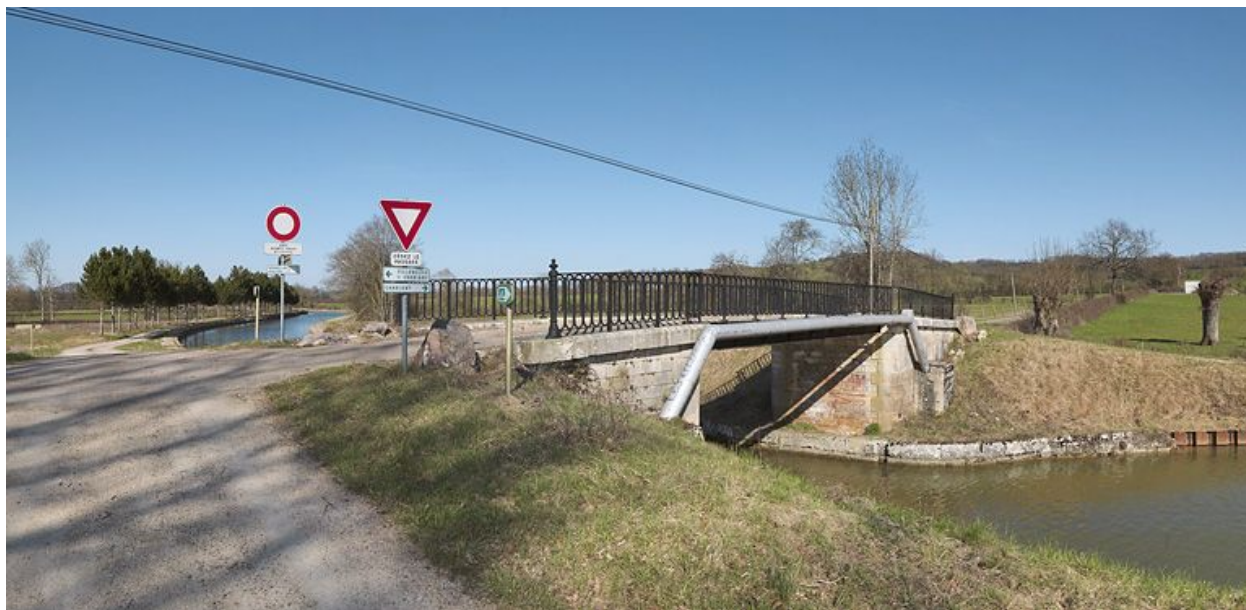
Le pont vu d'amont.
