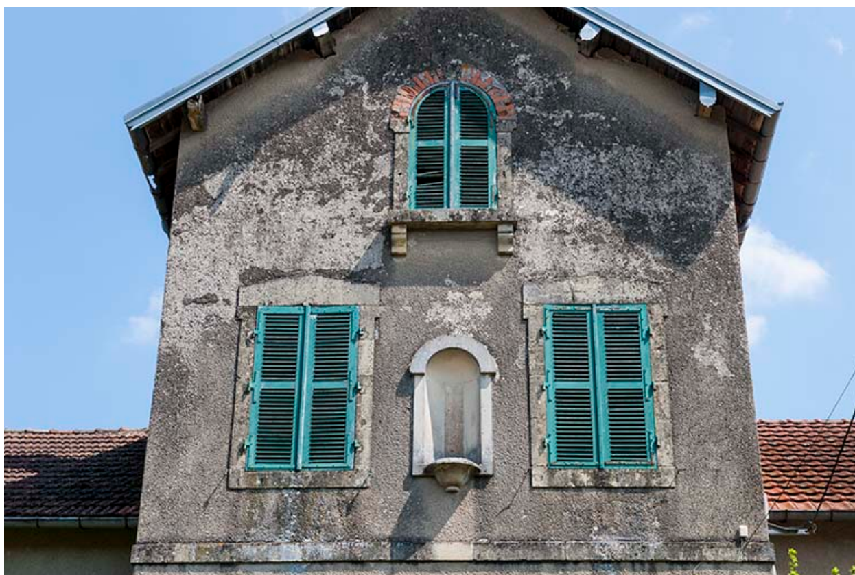
Détail sur la niche, façade principale.
