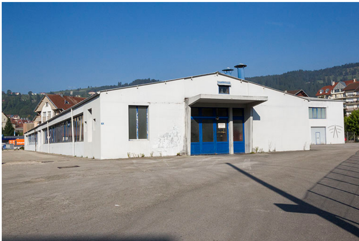
Bâtiment en rez-de-chaussée : extrémité orientale.
