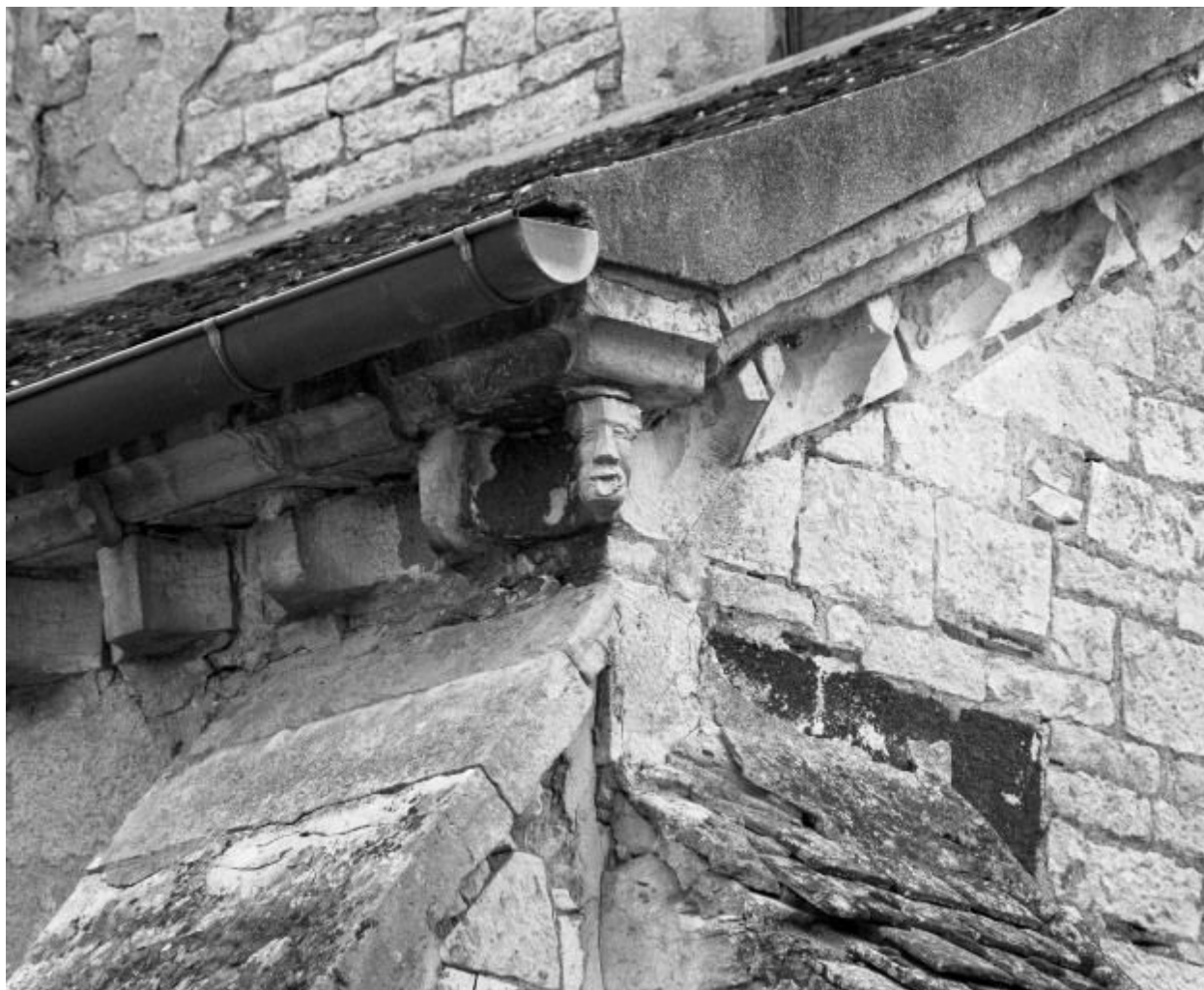
Façade : détail de l'angle du bas-côté gauche.
