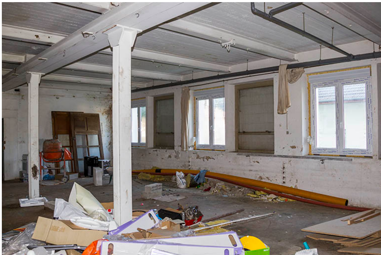
Atelier au rez-de-chaussée.
