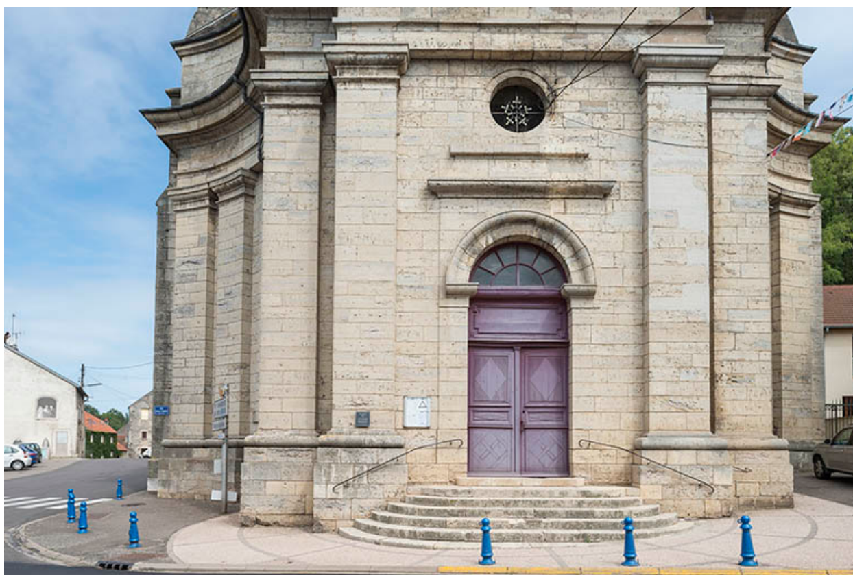
Le portail de l'église paroissiale.
