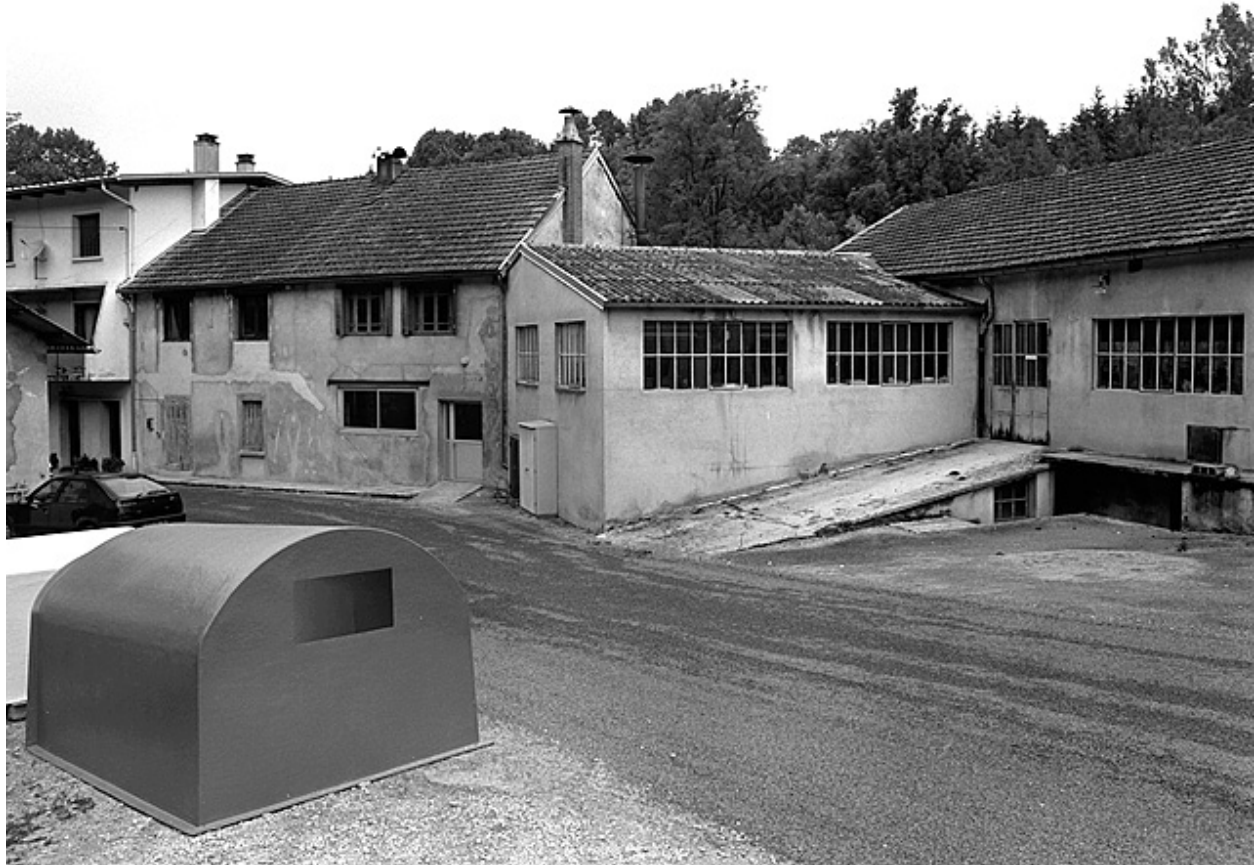
Bureau et atelier de fabrication.
