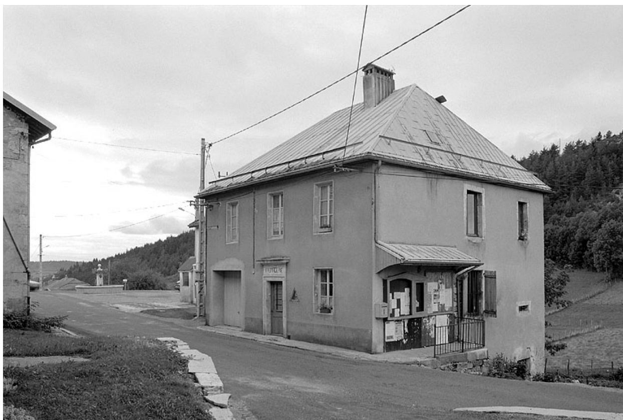
Façade antérieure et face latérale droite.
