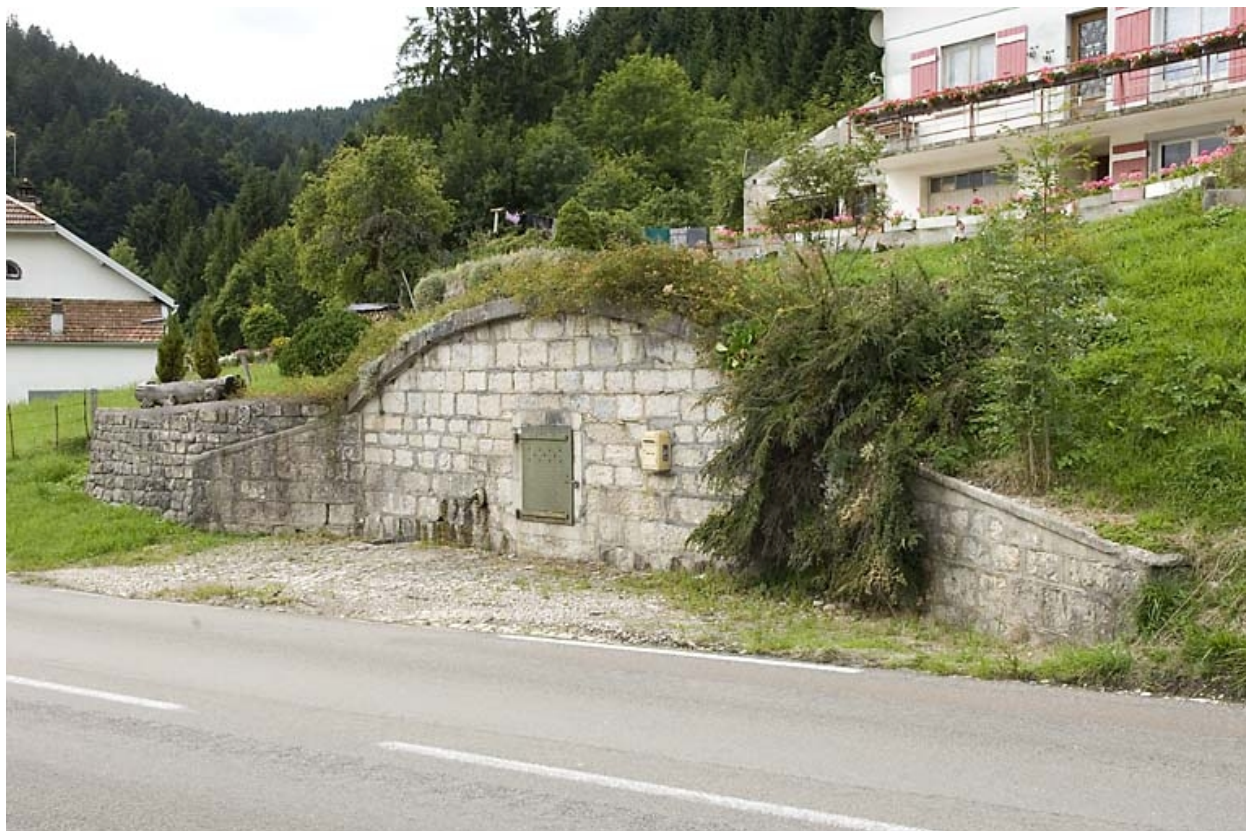
Réservoir des Tavins (route de Vallorbe, 2008 AH 16).
