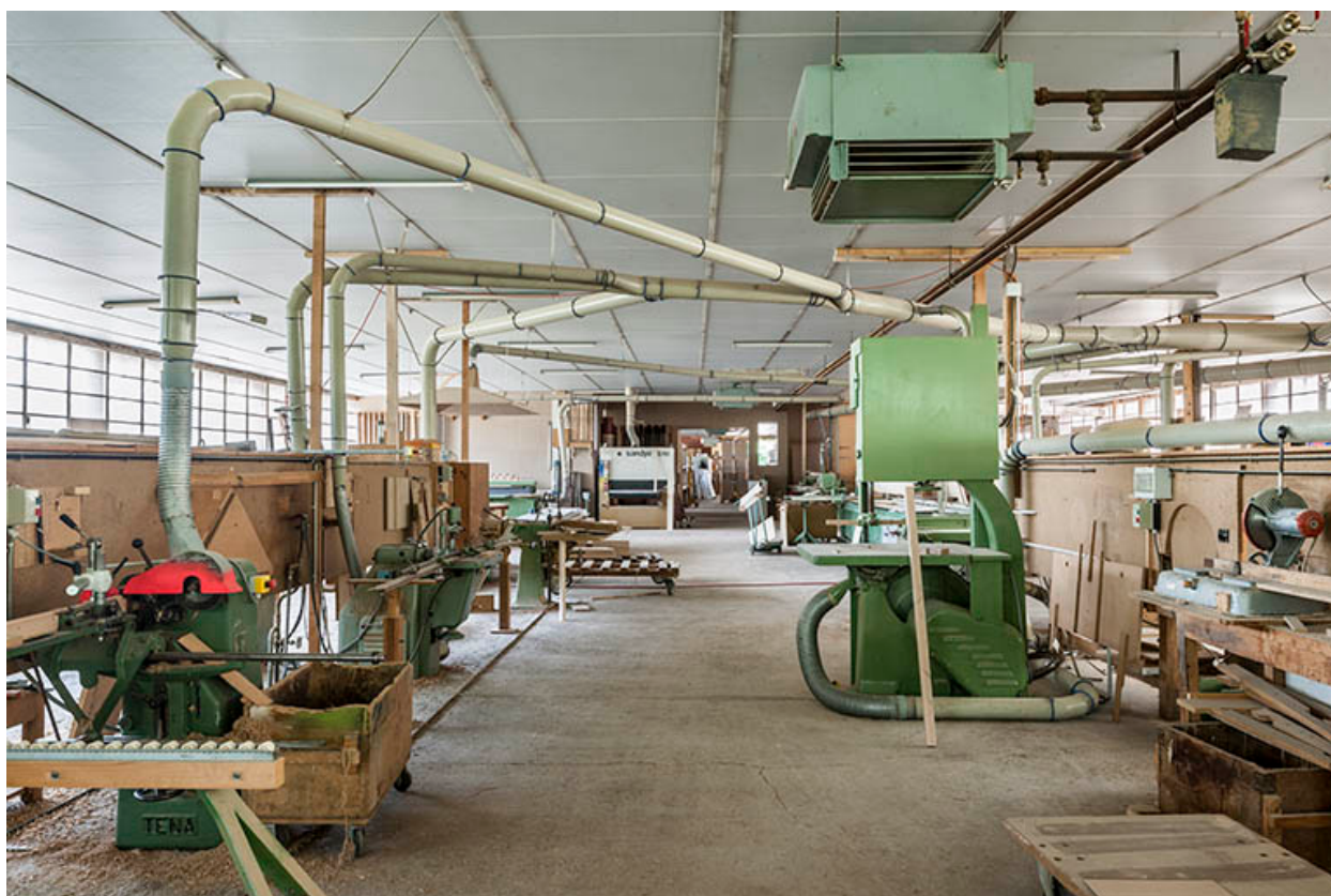
Atelier de menuiserie. Vue depuis le nord.
