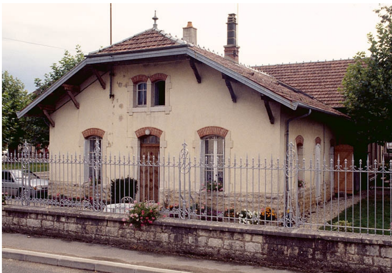
Mur-pignon et façade postérieure depuis l'ouest.
