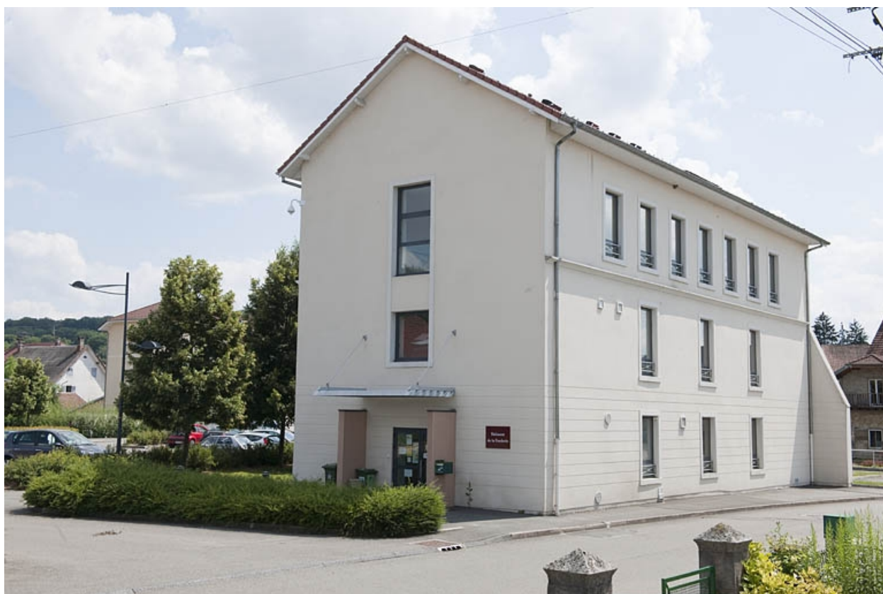
Bâtiment de bureaux. Vue depuis le nord.
