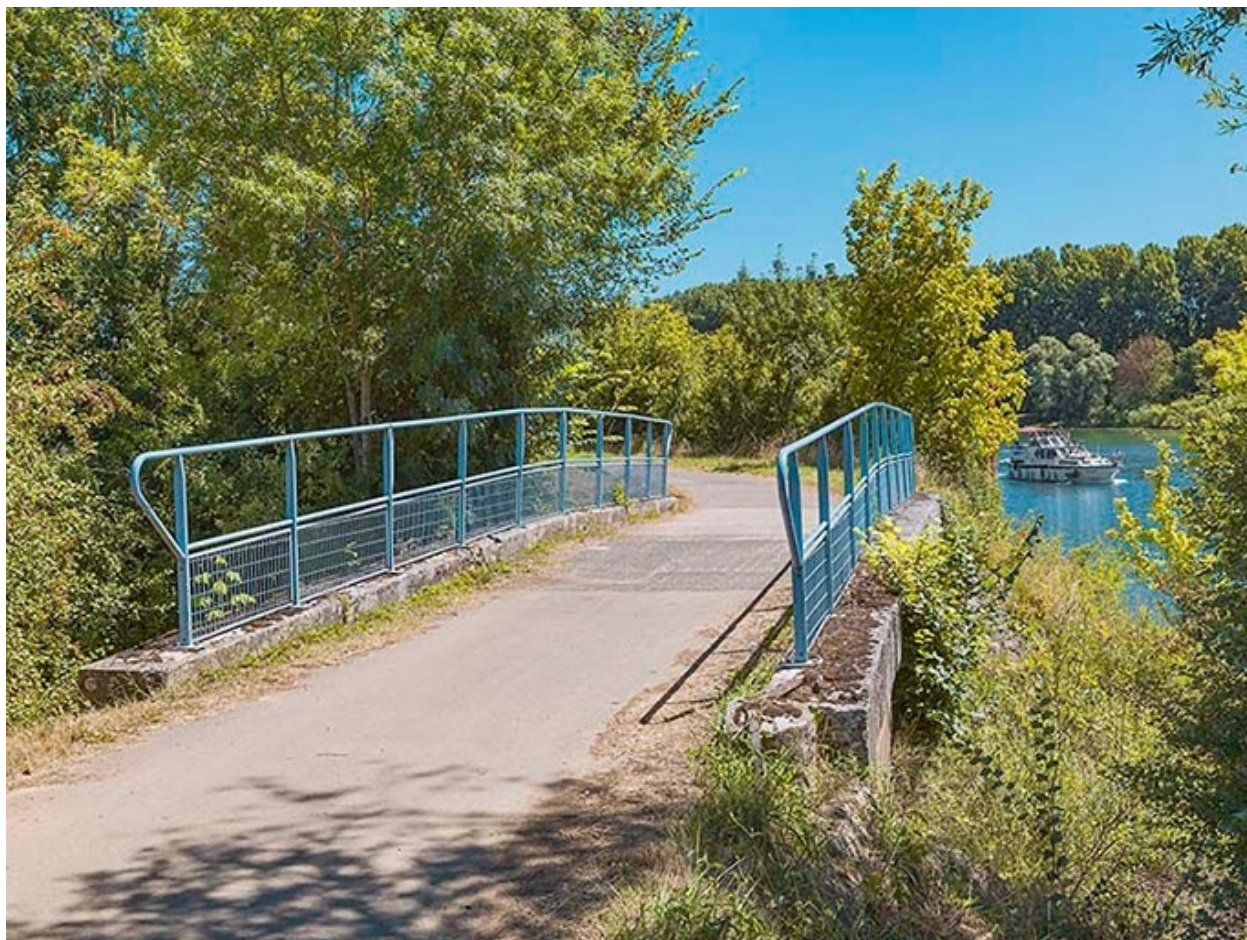
Vue d'ensemble du pont, d'aval.
