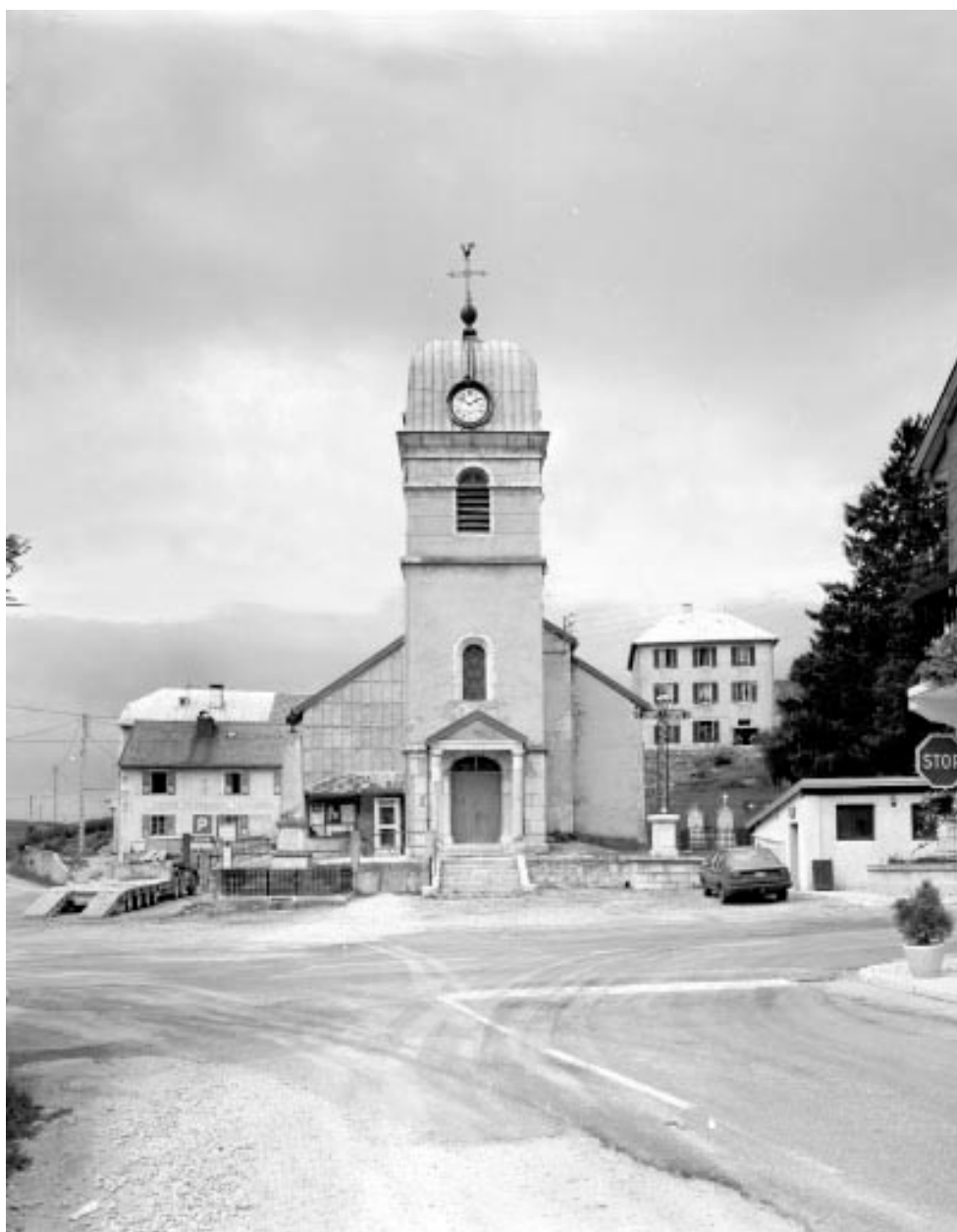
Extérieur : façade occidentale.
