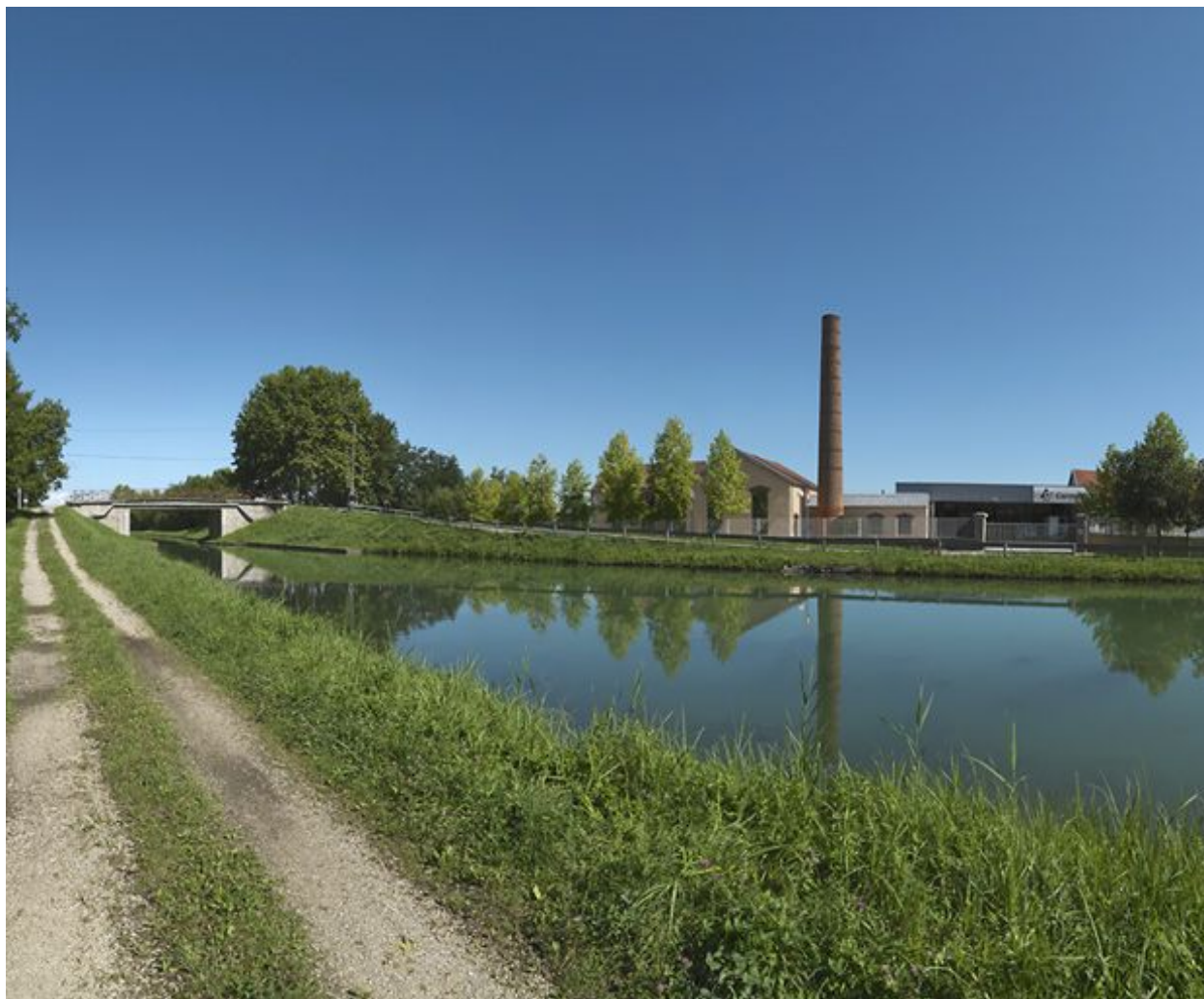
Vue d'ensemble du site industriel.
