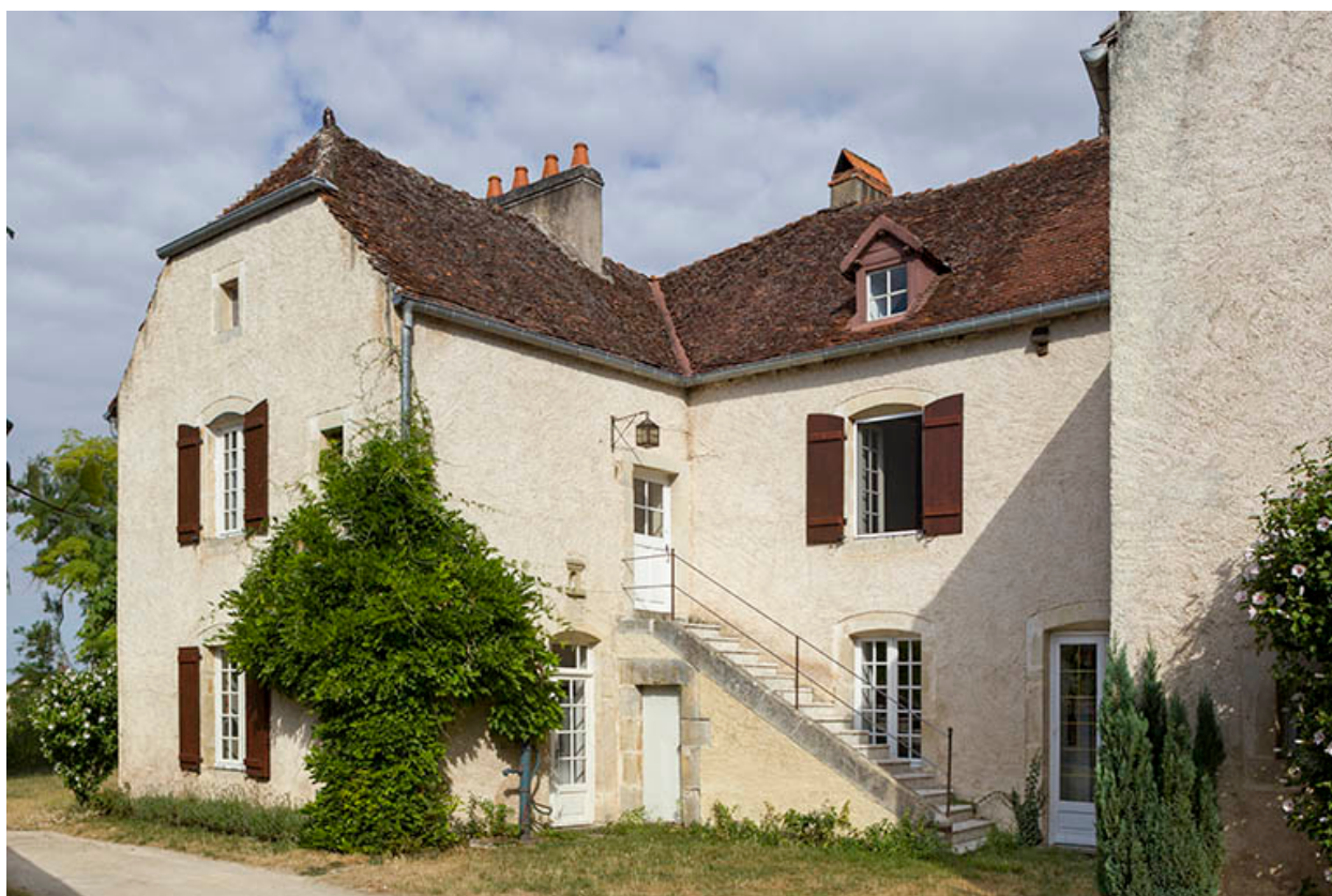
Vue générale sur la cour.
