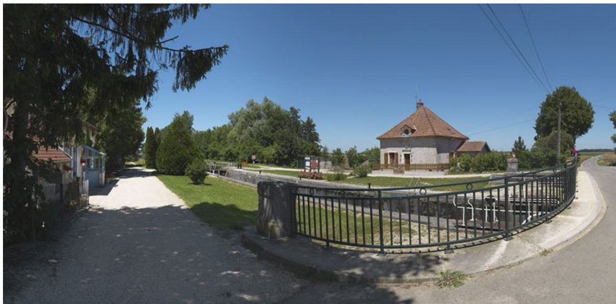
La maison éclusière.
