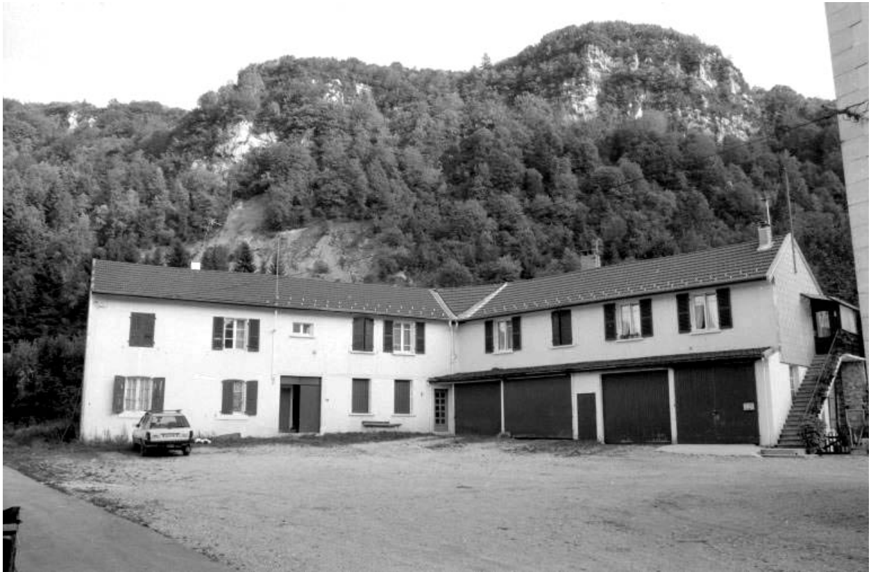
Anciens logements d'ouvriers.
