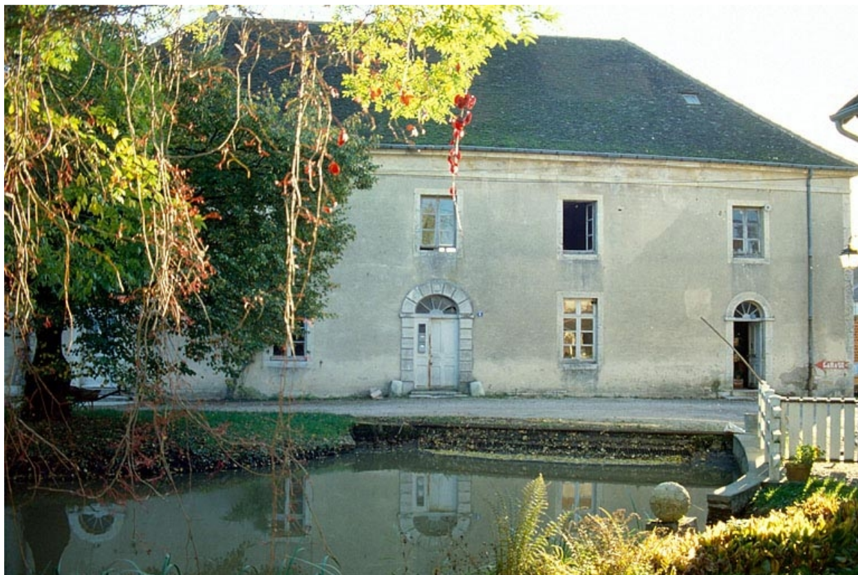
Façade antérieure de la minoterie.
