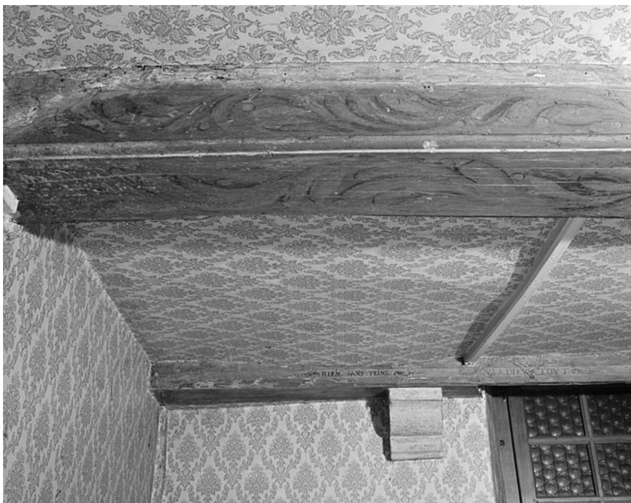
Premier corps de bâtiment. Plafond du rez-de-chaussée.
