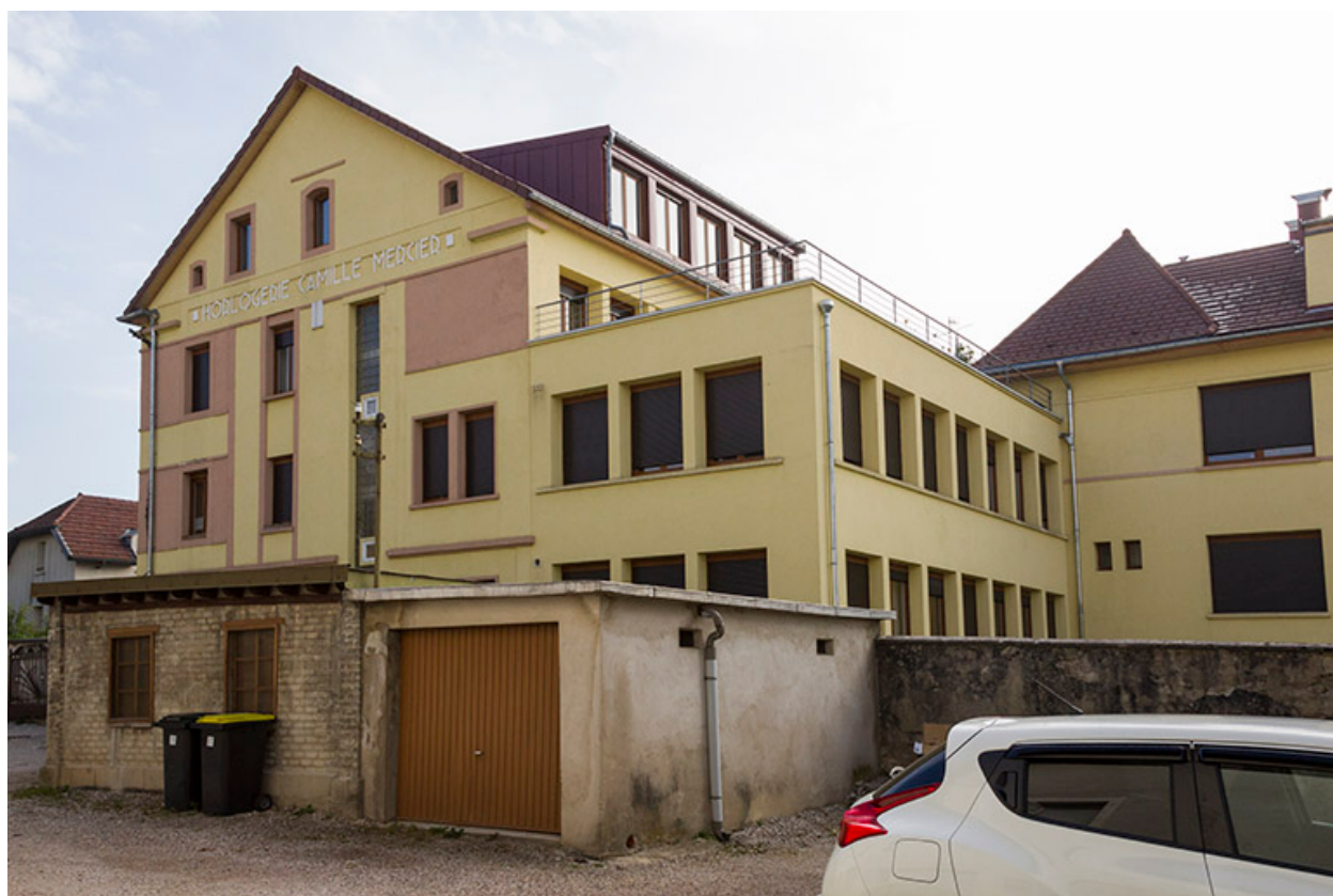
Immeuble et extension, depuis le sud-ouest.
