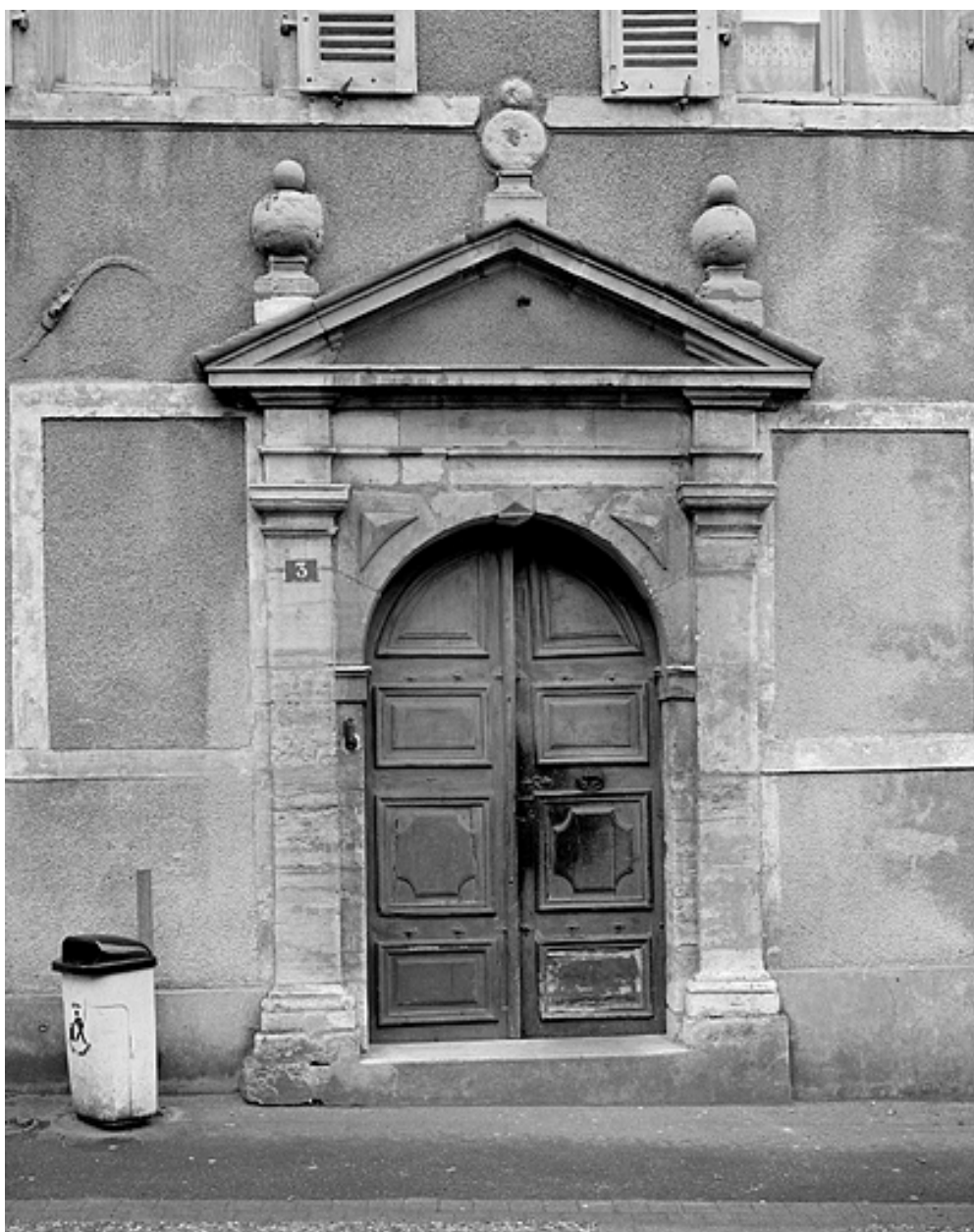
Portail d'entrée de face.
