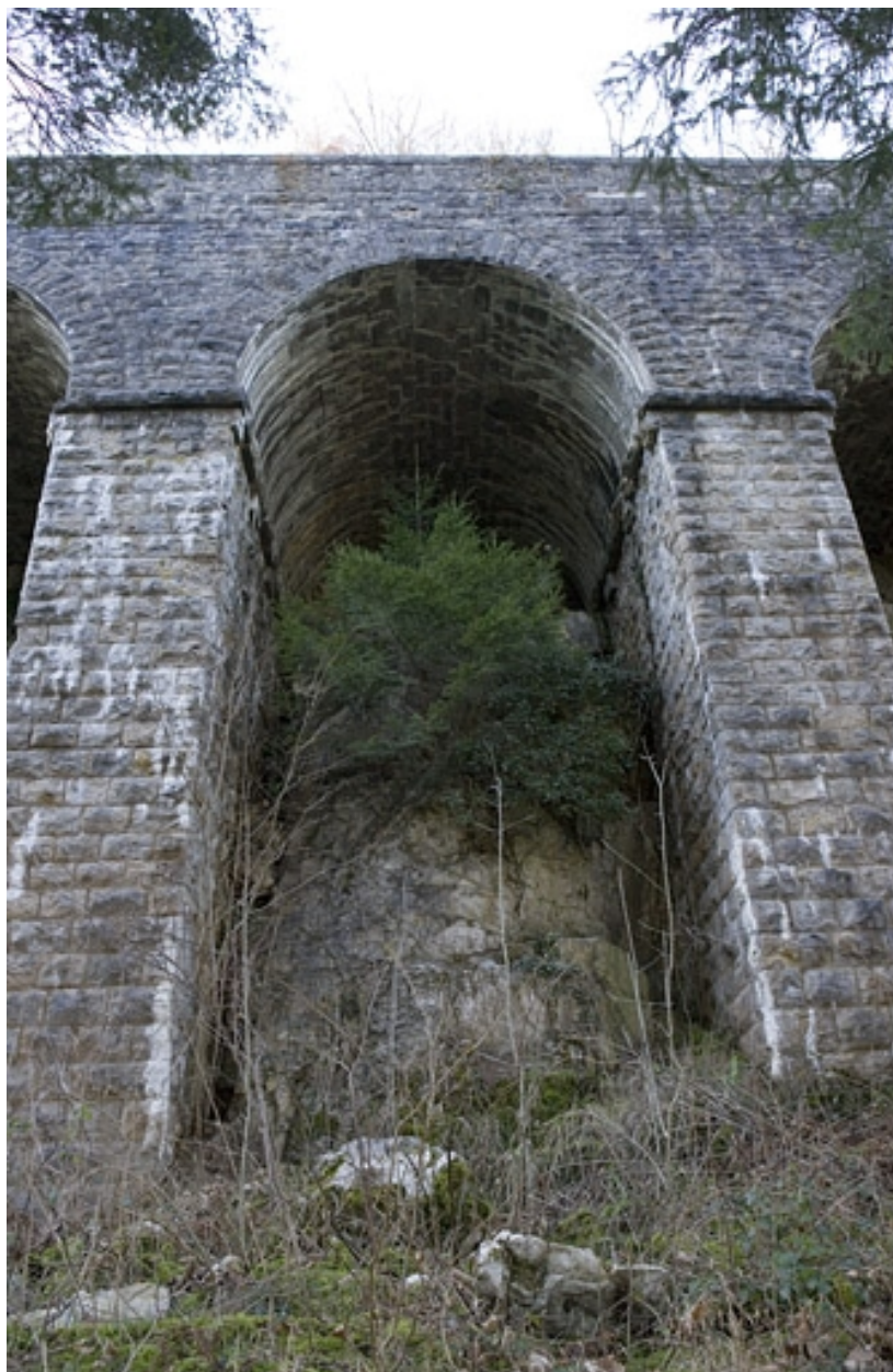
Deuxième mur à arcades : arche enjambant le rocher.
