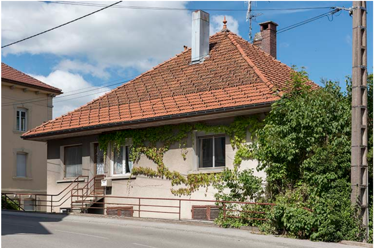
Façade postérieure (rue du Maréchal Foch).
