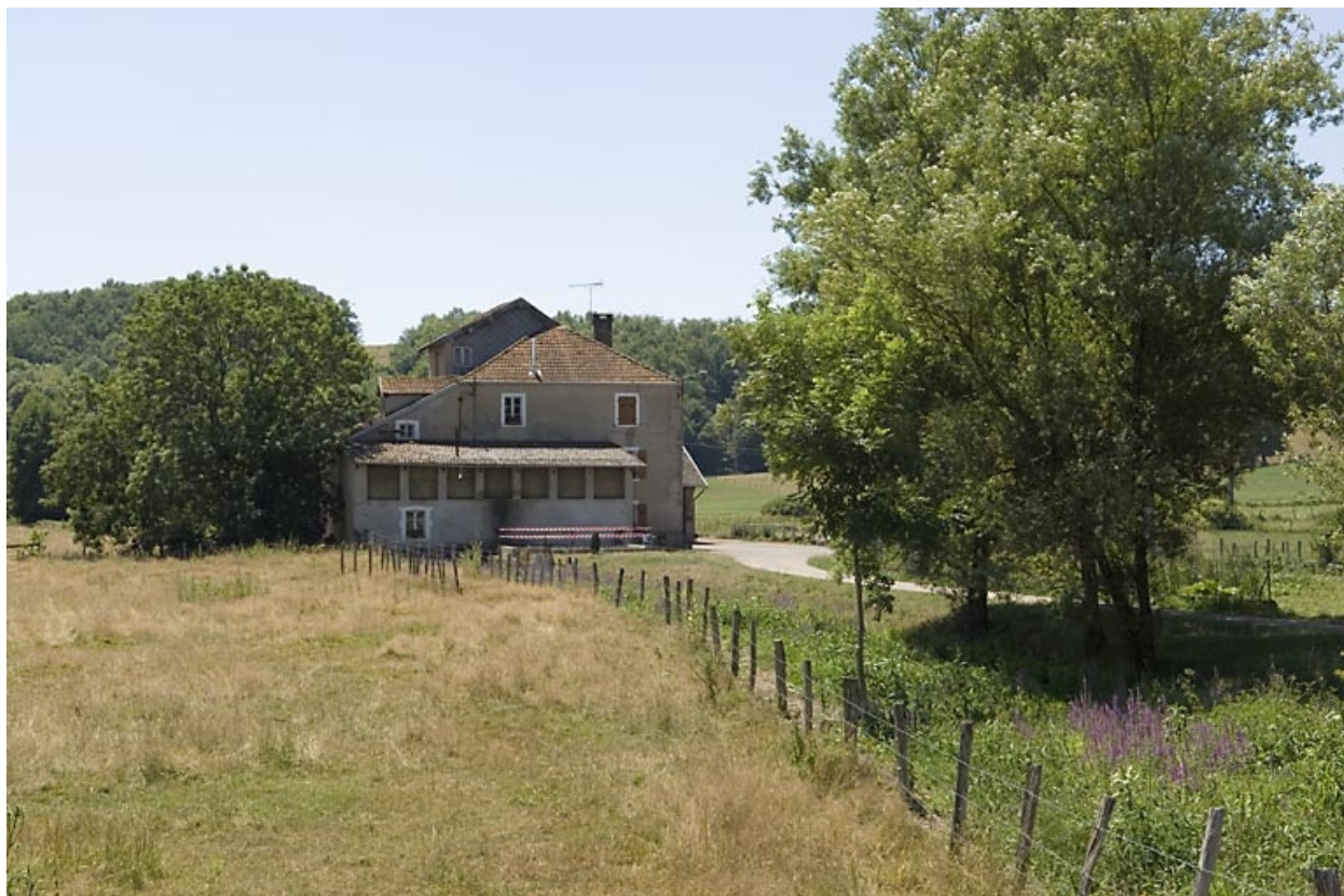
Vue depuis l'amont.
