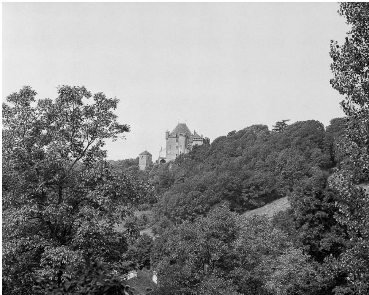
Le château fort vu depuis le sud.
